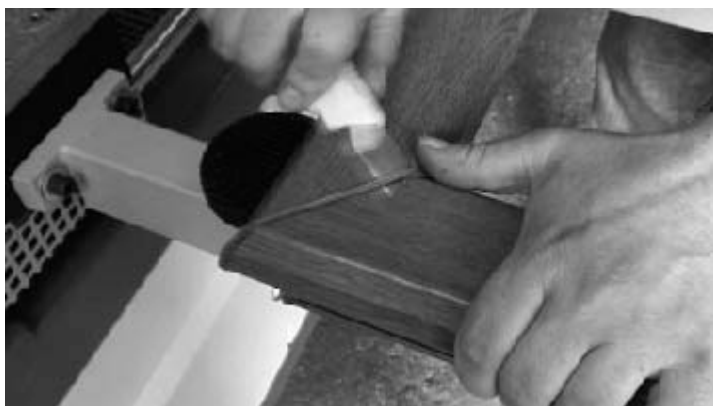
Рисунок 5.5-9 Зачистка сварного шва 0,2 mm
